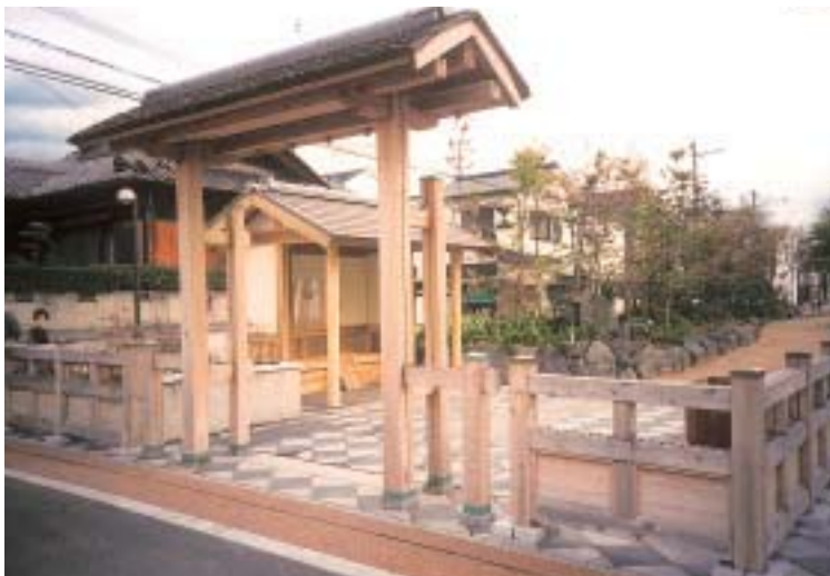
歩行路15号線整備
