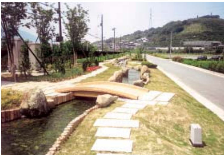
伊都浄化センター
