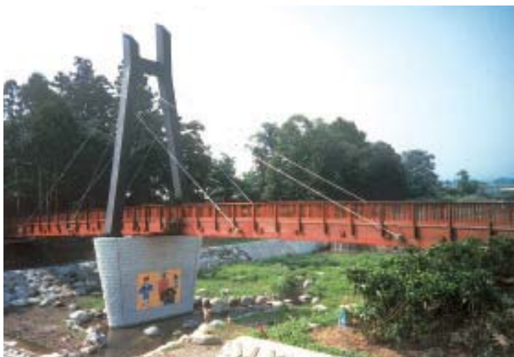
地方特定環境整備工事
