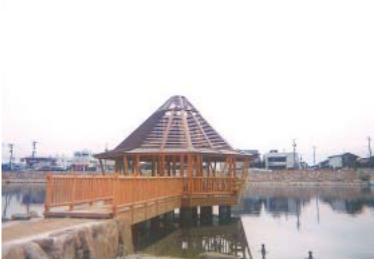
小河川改修工事
