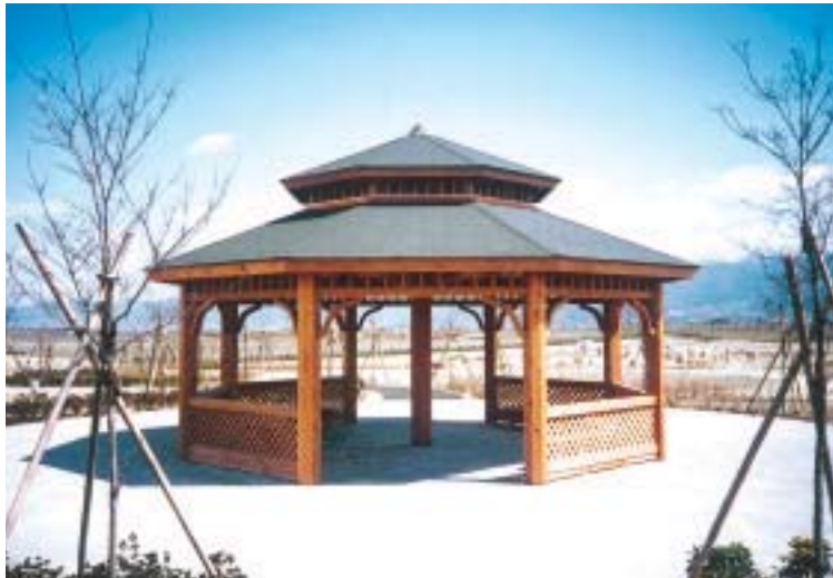
松本空港周辺整備工事
