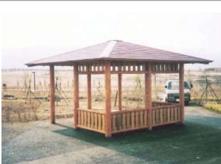
松本空港周辺整備工事
