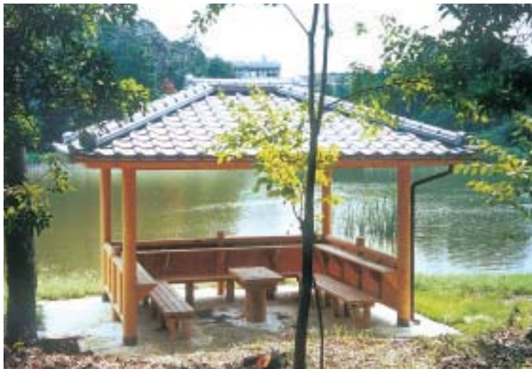
深田池整備工事
