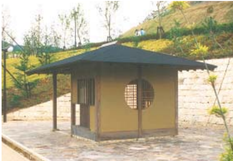
四季の郷整備工事
