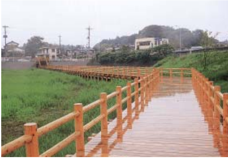
せせらぎ広場整備
